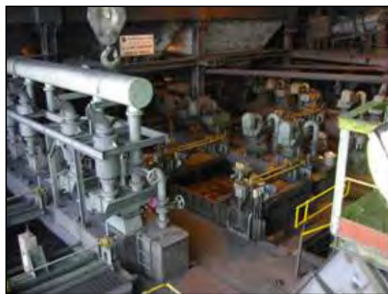
写真 6.3.2 ジグ水選機の改造
