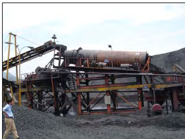
写真 6.3.7 簡易選炭設備
