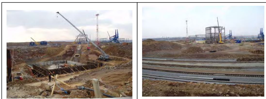
写真 2. 3. 7 貨車反転装置基礎工事現場と貨車引き込み線路
