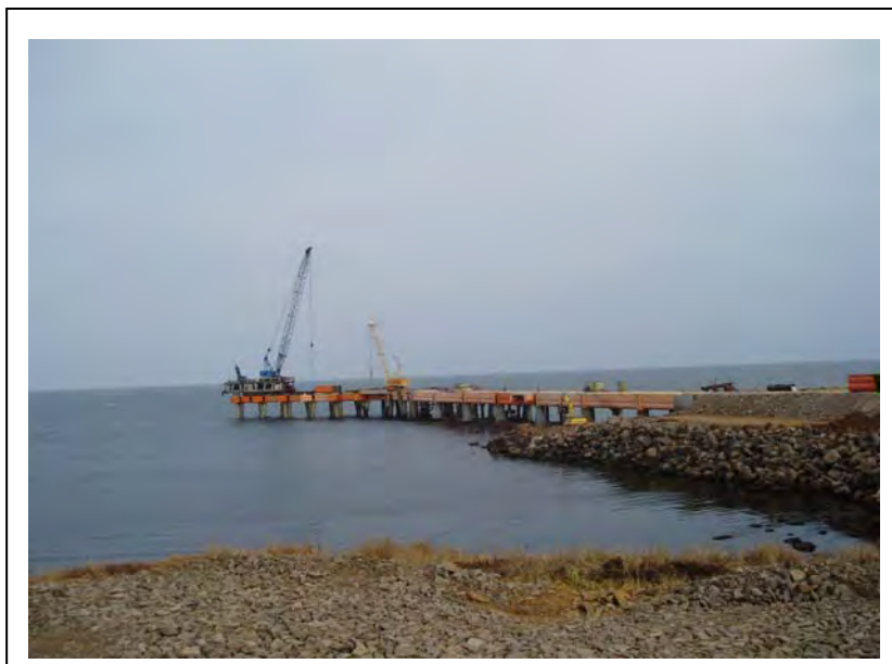
写真 2. 3. 6 ムチカ湾・SUEK 石炭ターミナルの建設中の埠頭
