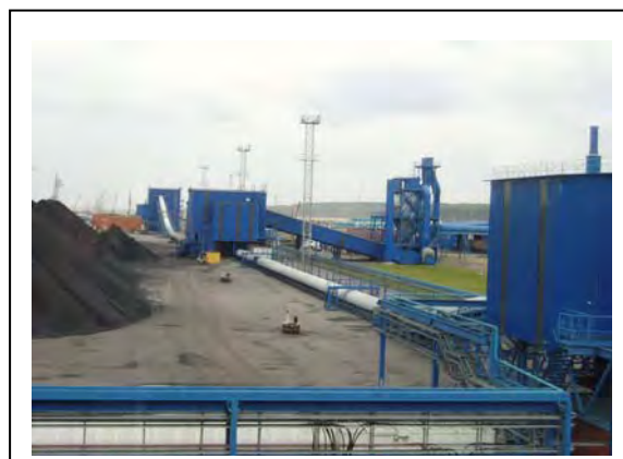
写真 2. 3. 18 散水機と粉砕機建家
